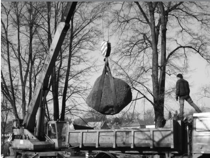
Zavěšený kámen na rameni jeřábu těsně před usazením
