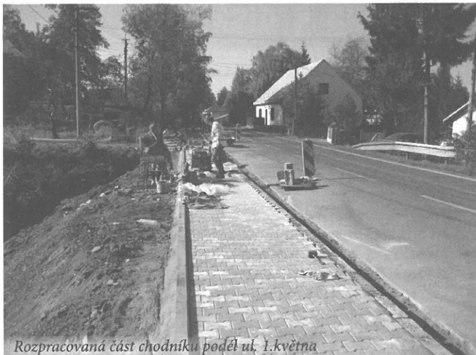
Podkladní „kufří“ pod cyklostezkou se již rysuje
