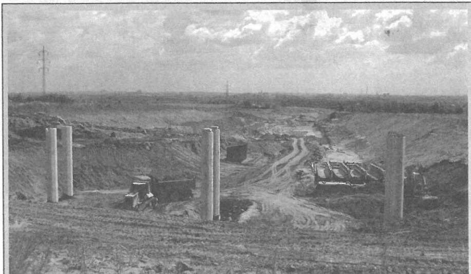
DÁLNIČE D 47 Výstavba dálnice nezadržitelně pokračuje také na našem území. Na silnici Janovské se už tyčí pilíře prvního mostu, kterých bude na úseku dálnice v Polance nad Odrou celkem tři.
