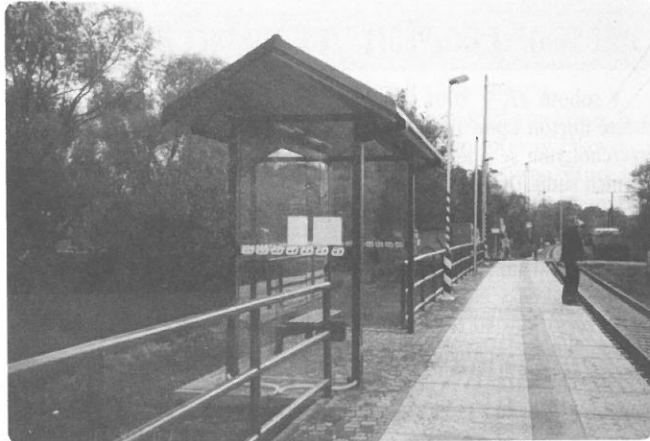
Moderní čekárna nové vlakové zastávky v Polance nad Odrou
