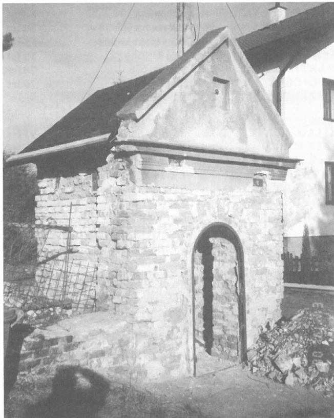
Zahájené práce na opravě kapličky sv. Vendelína
