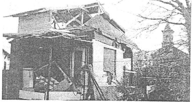
Ruina domku č. p. 232 na ul. 1. května (za trať), bývalý „Petrovičův restaurant“
