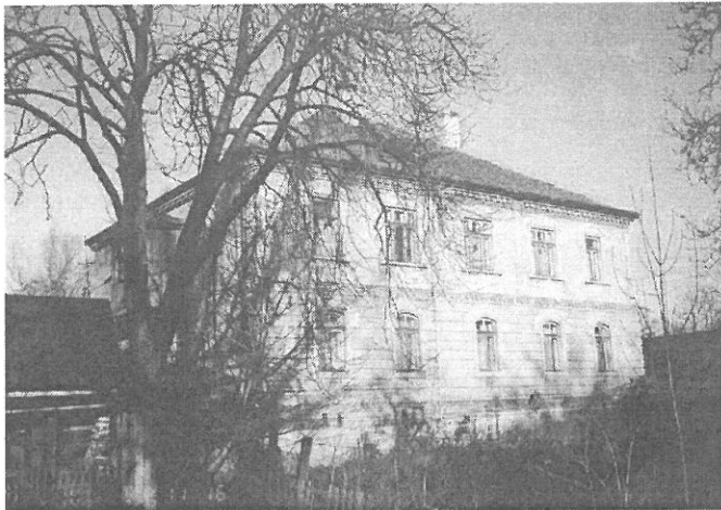
Budova č. p. 476 na ul. Janovské těsně před rekonstrukcí na dům s pečovatelskou službou.
